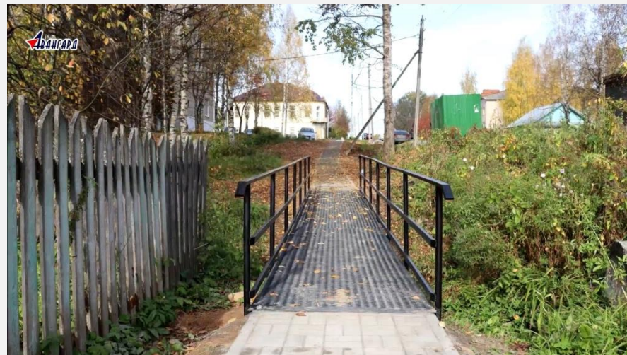
Пешеходный мостик ул. Ленина
