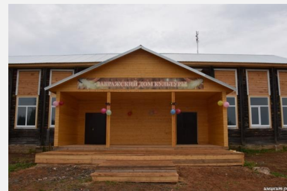
Ремонт Завражского дома культуры
