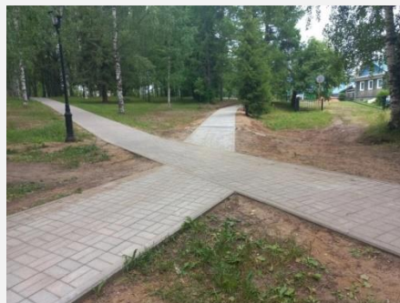
Благоустройство городского парка, 5 этап
