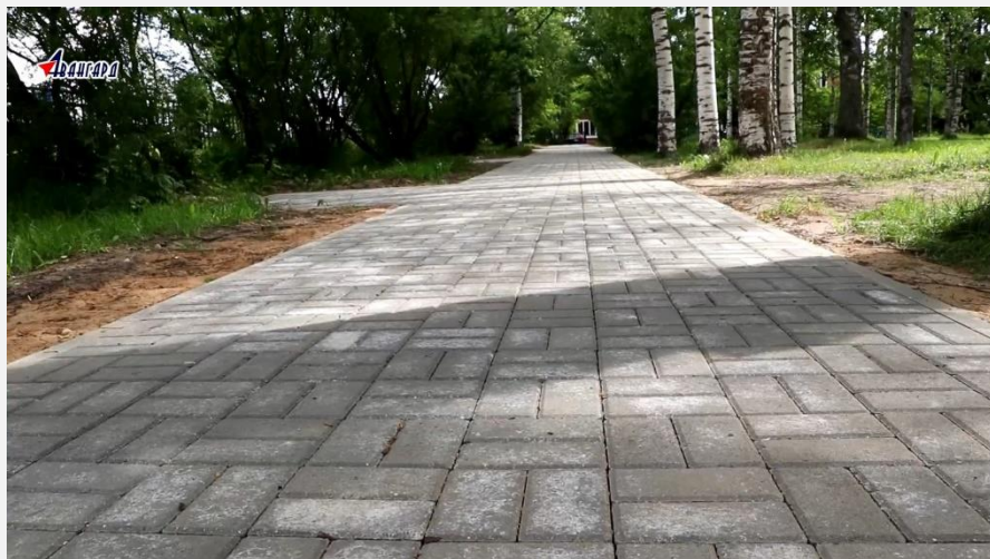
Укладка дорожки из брусчатки
